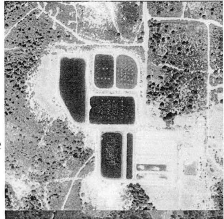
Mt. Shasta WWTP - 1994
